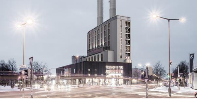
KARE Design Kraftwerk, Munich (D)
