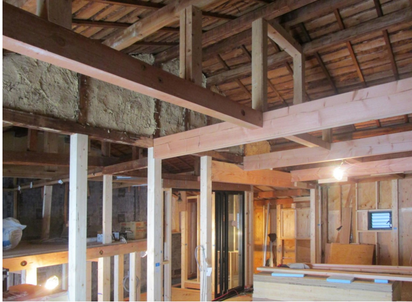
Ristrutturazione di edificio residenziale a Osaka
